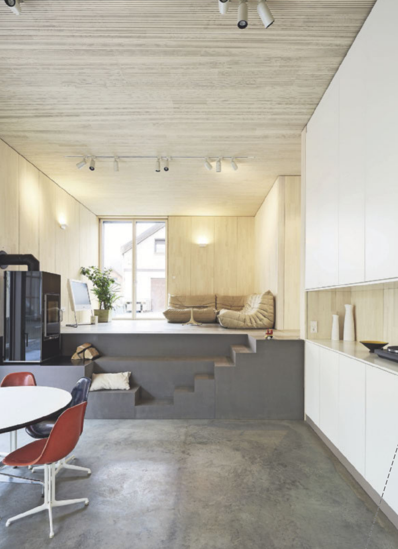
Innen sind die Bauteile werkseitig mit hochwertiger Sichtholzoberfläche ausgestattet. Die Akustikprofilierung an den Deckenbauteilen optimiert zudem die Raumakustik im offenen EG.
