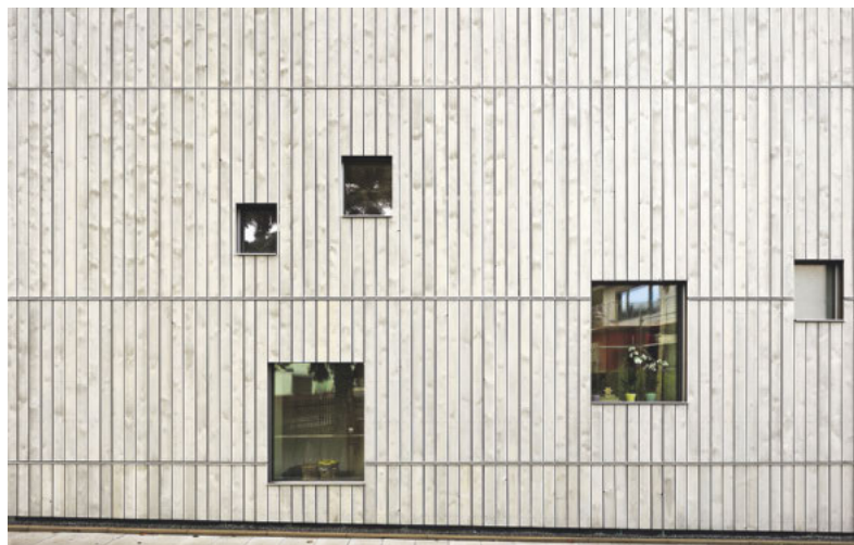
Die Flexibilität des Grundrisses spiegelt sich an der Fassade im lebhaften Fensterbild mit unterschiedlichen Formaten.
