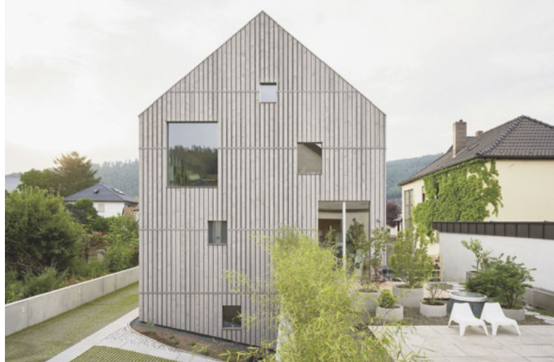
Der Neubau wurde komplett aus tragenden Massivholzbauteilen für Wand, Decke und Dach konstruiert.
